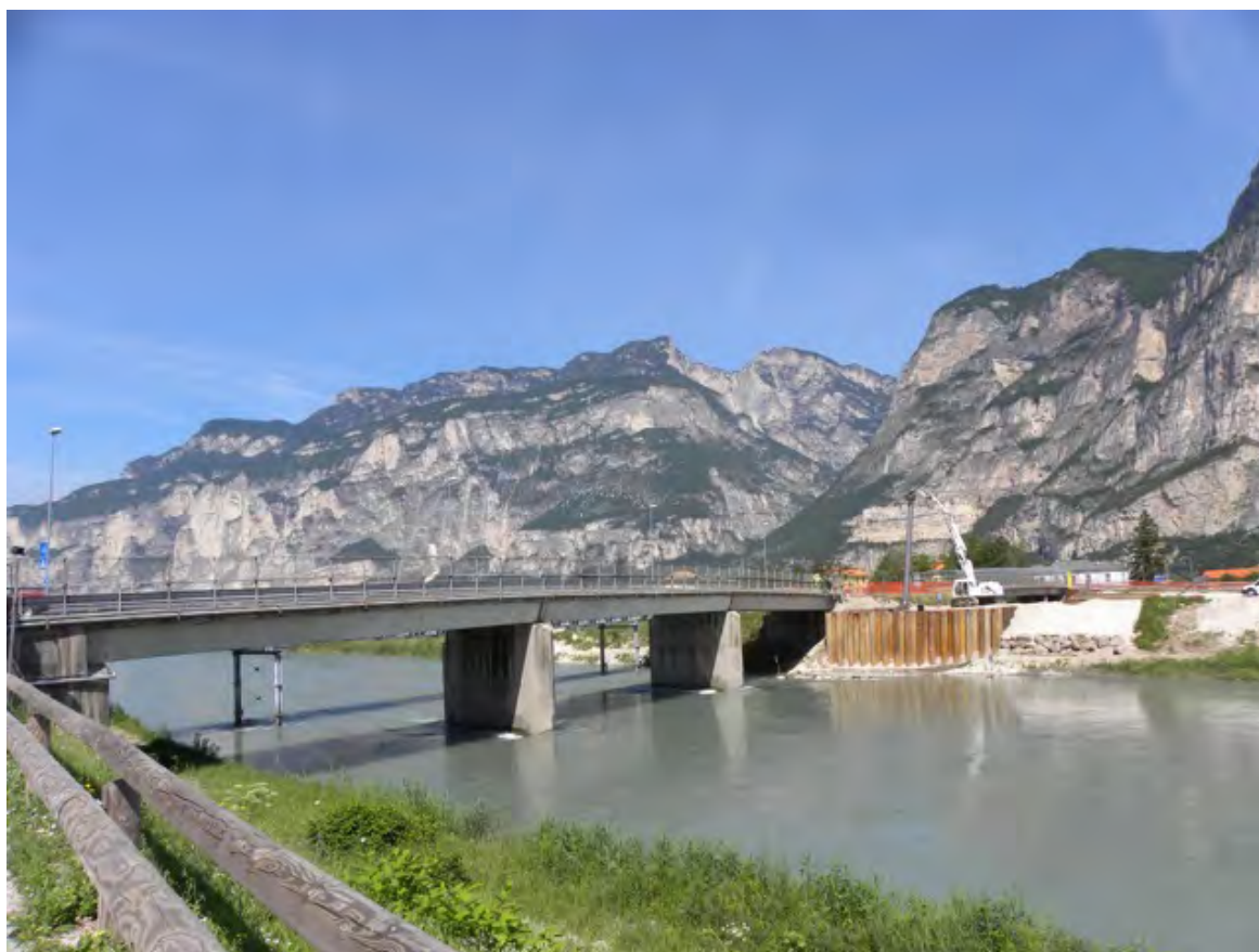
De brug over de Etsch (Adige in Trentino) bij het binnenrijden van Salurn
