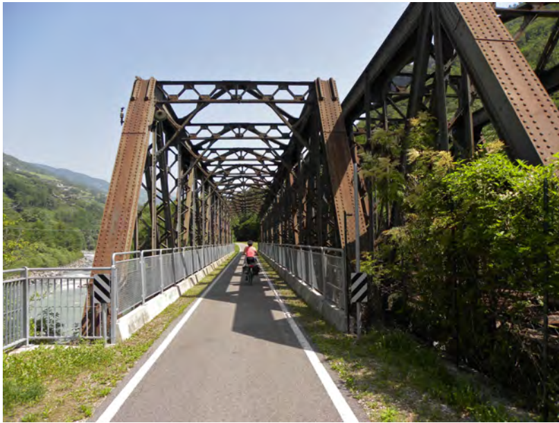
Mooie nieuwe bestemming van een oude spoorwegbrug
