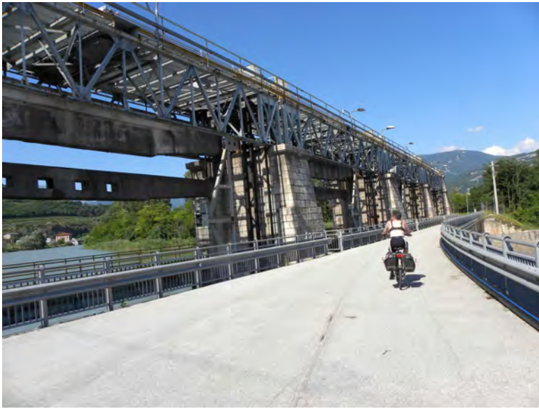
het sluisencomplex nabij Mori
